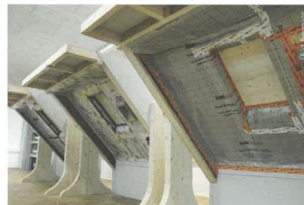
Die Schmetterlingsmodelle bieten den Azubis die Gelegenheit, das Kleben einer luftdichten Ebene am 1:1-Modell zu lernen und zu perfektionieren.
